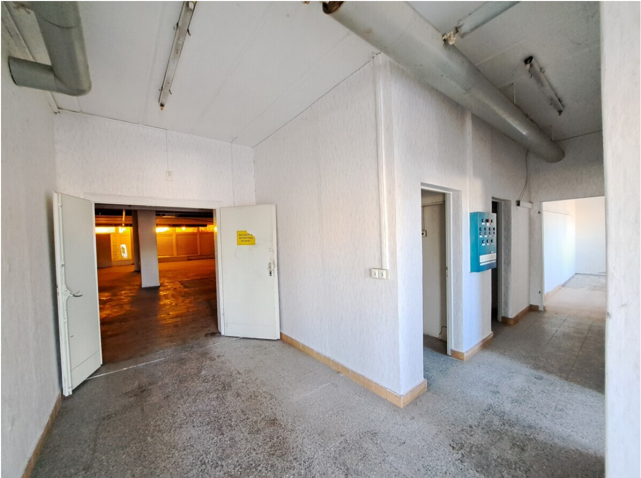
Eingangsbereich / Flur mit Zugang zum ehemaligen Verkaufsraum
