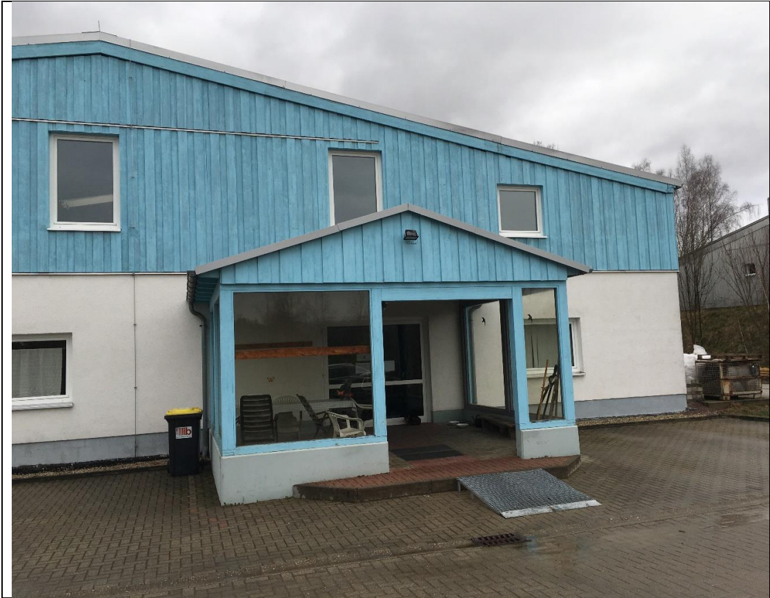
Gewerbehalle: Eingangsbereich mit Windfang
