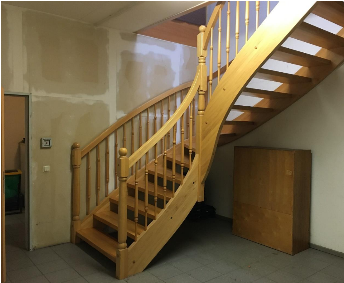
Gewerbehalle: Treppe ins 1. OG
